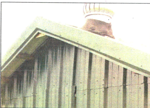
Esta pequeña casa móvil tiene una entrada de aire al fin de la pared y una ventila en forma de abanico rotativo en el techo para permitir que el aire y la humedad escapen.
