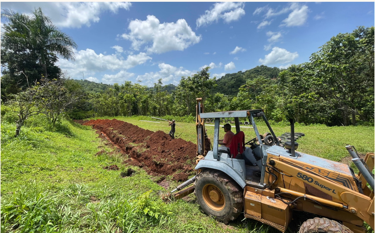
Digger excavando zanja para enterrar tubería de riego.
